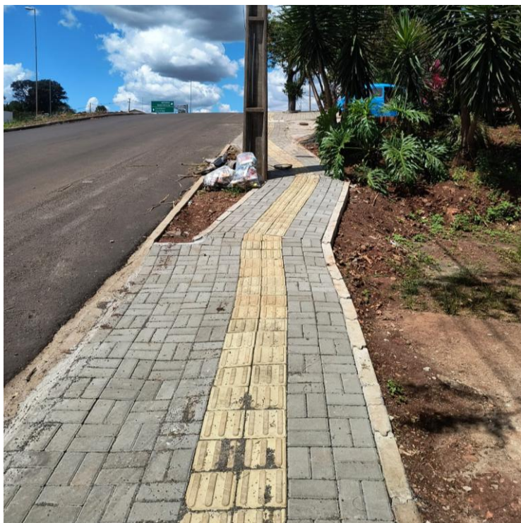
Figura 2 - Detalhe de passeio executado - Obra JK
