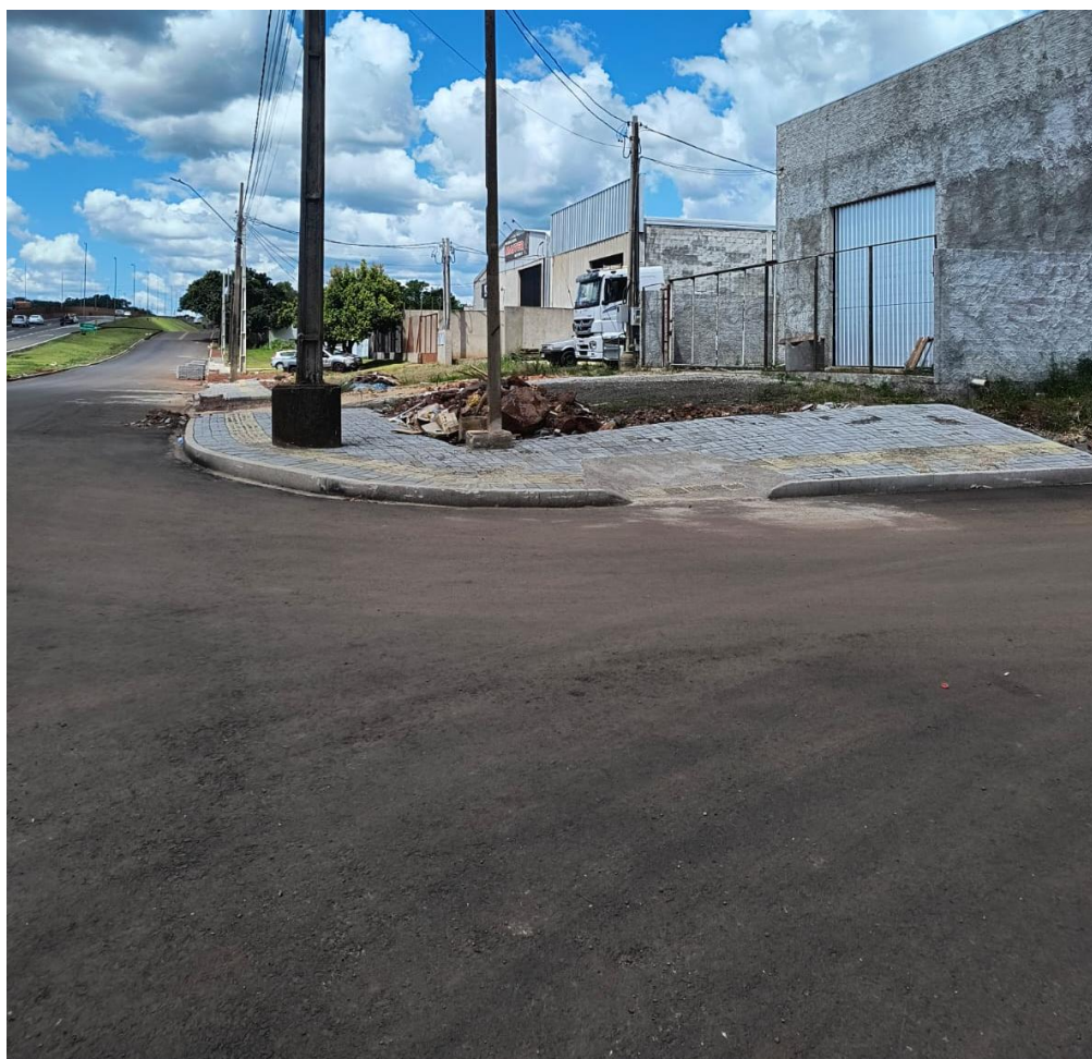
Figura 3 – Execução de passeio
