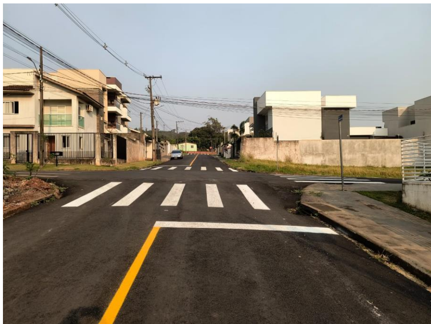
Figura 2 - Implantação de Sinalização Horizontal
