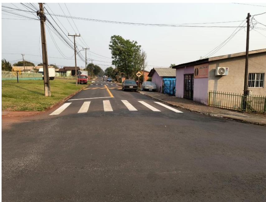
Figura 3 - Implantação de Sinalização Horizontal
