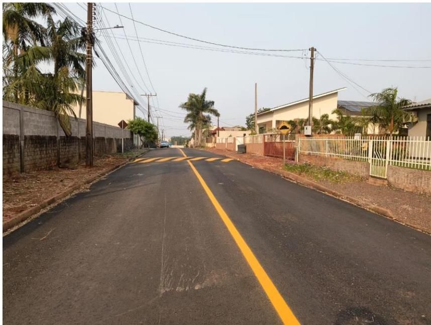
Figura 1 – Implantação de Sinalização Horizontal
