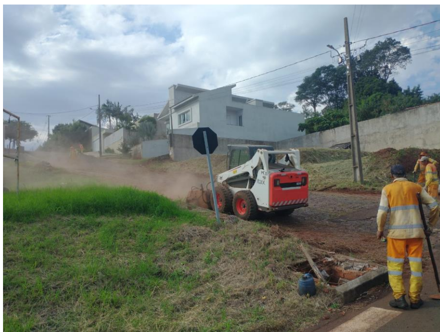
Figura 2 - Serviços preliminares de limpeza de sarjetas e avanço de terra sobre as ruas
