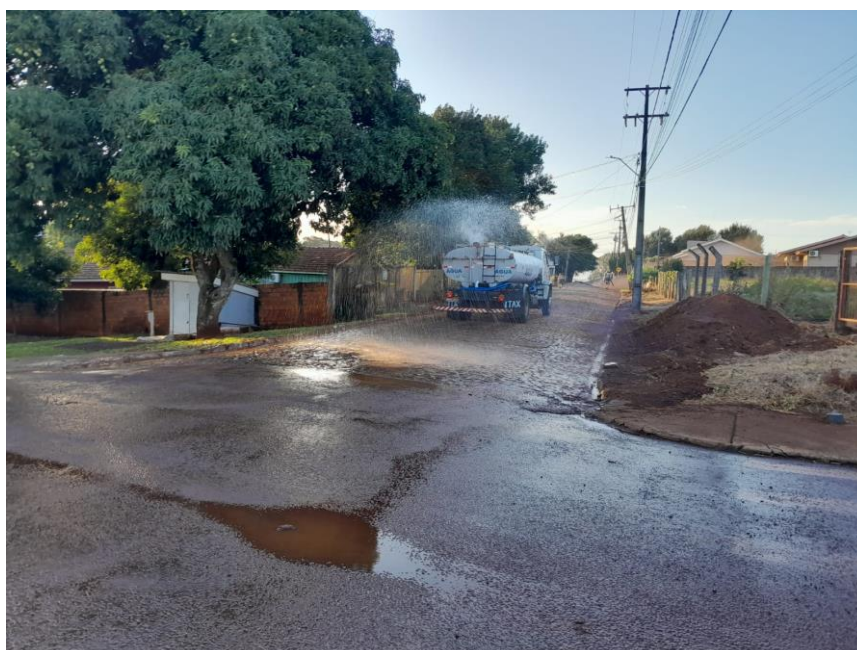
Figura 4 - Aplicação de Jato de água para remoção de resíduos e terra/ limpeza
