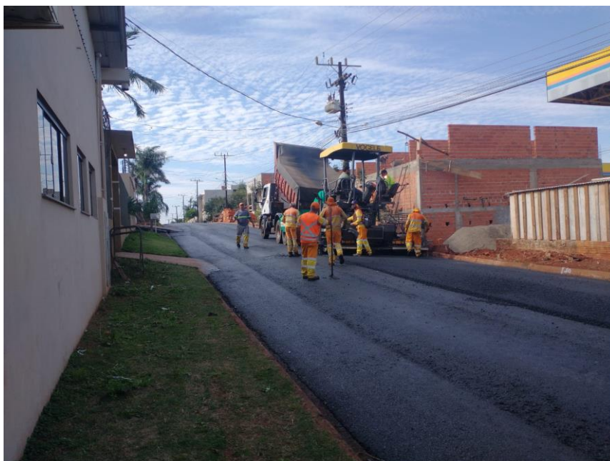
Figura 11 -Implantação da capa de rolamento em CBUQ
