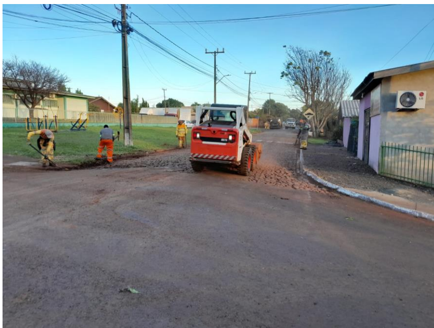
Figura 3 - Serviços preliminares de limpeza de sarjetas e avanço de terra sobre as ruas
