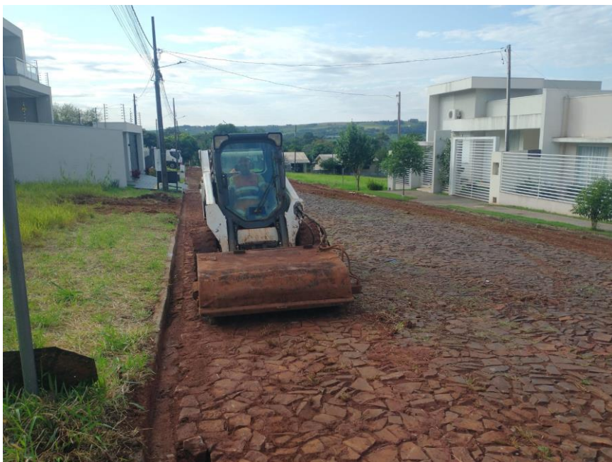
Figura 1 - Serviços preliminares de limpeza de sarjetas e avanço de terra sobre as ruas
