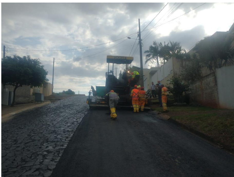
Figura 6 - Aplicação de Reperfilamento pós pintura de ligação
