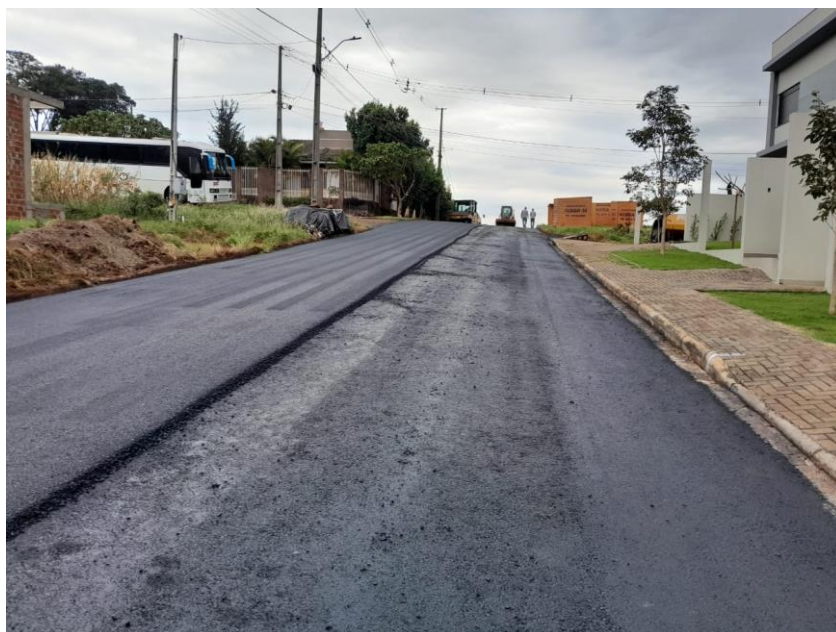
Figura 9 - Implantação da capa de rolamento em CBUQ pós pintura de ligação
