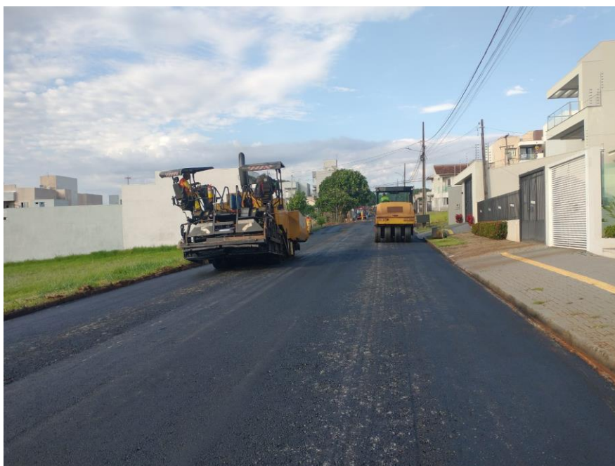
Figura 7 - Aplicação do Reperfilamento
