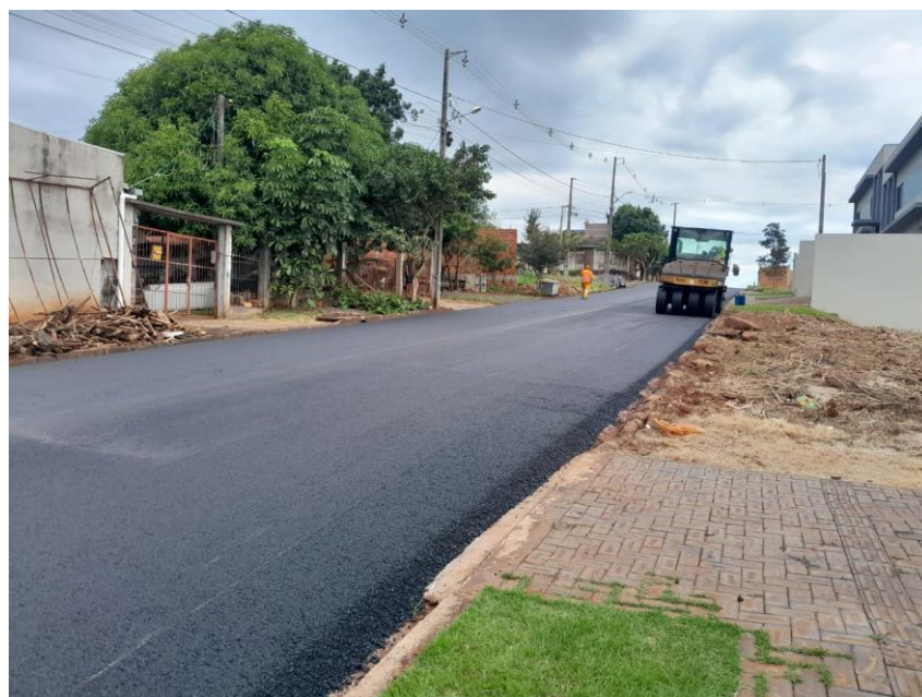
Figura 12 - Recape e Reperfilamento implantado na Rua General Dutra
