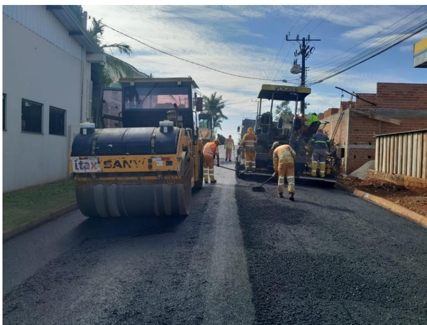
Figura 10 -Implantação da capa de rolamento em CBUQ
