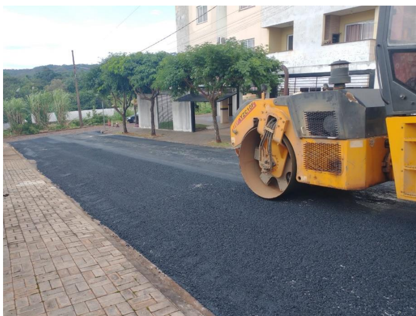
Figura 8 - Aplicação do Reperfilamento
