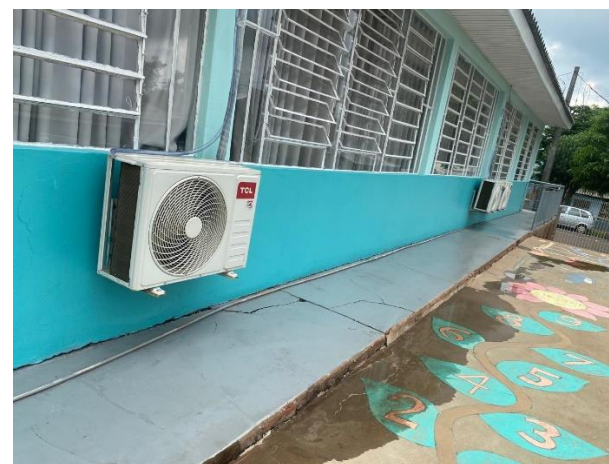
Pintura das janelas
