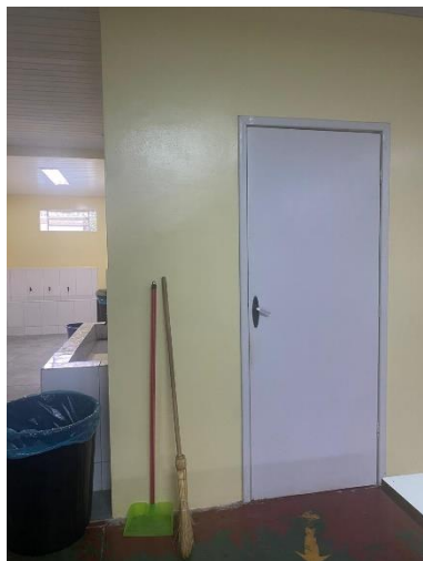
Tratamento de umidade – Parede
