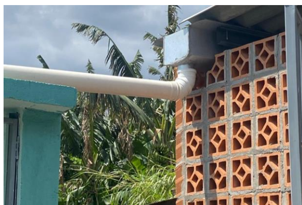
Calha e condutor
