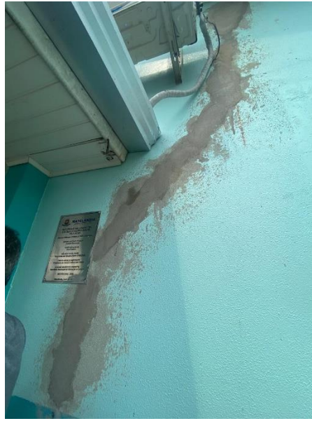
Tratamento de Fissura
