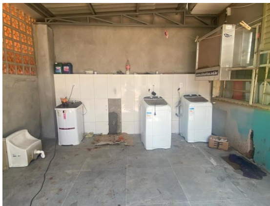
Revestimento Cerâmico piso e parede (lavanderia)
