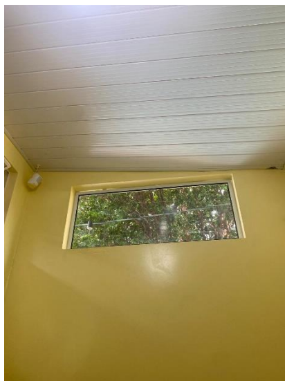
Troca da Janela
