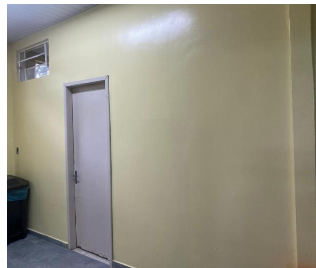
Fechamento da porta com alvenaria
