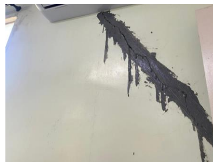
Imagem – Tratamento de Fissura
