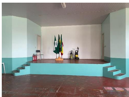
Imagem – Pintura Interna
