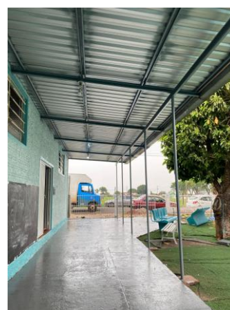
Imagem – Pintura de piso
