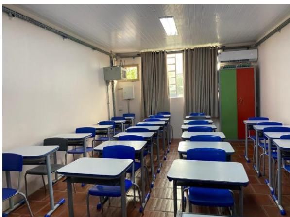
Imagem – Pintura Interna
