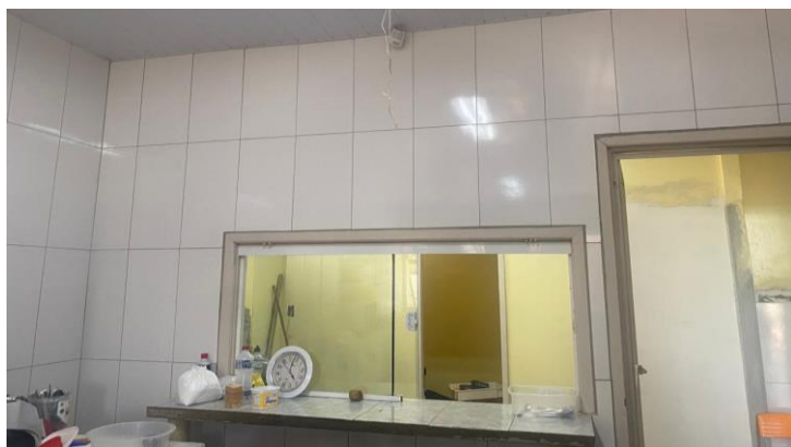
Revestimento cerâmico (parede) na cozinha
