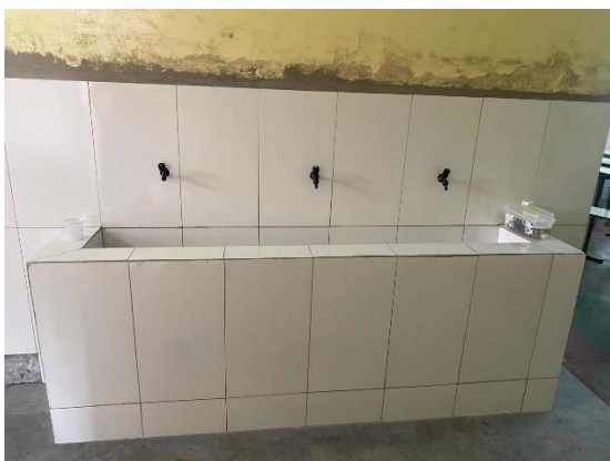
Revestimento cerâmico (parede) na área de higienização
