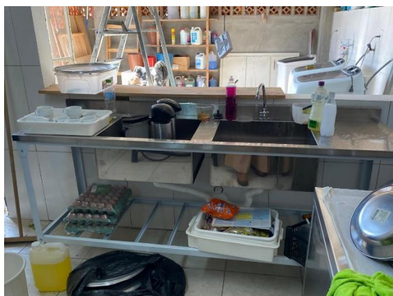
Instalação da pia da cozinha
