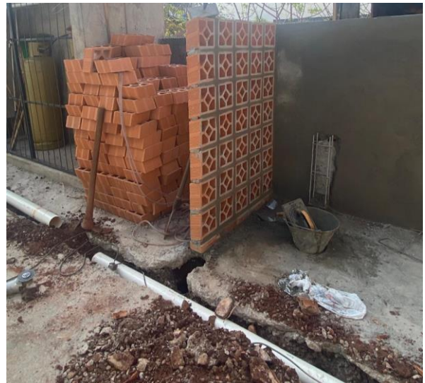
Parede de cobogó
