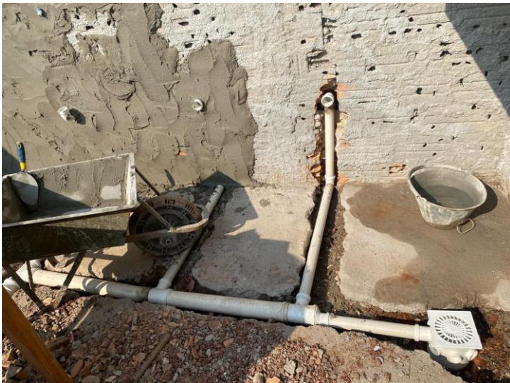
Instalação de esgoto
