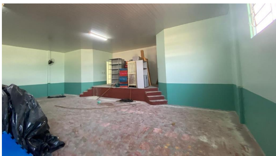
Pintura interna – Multiuso
