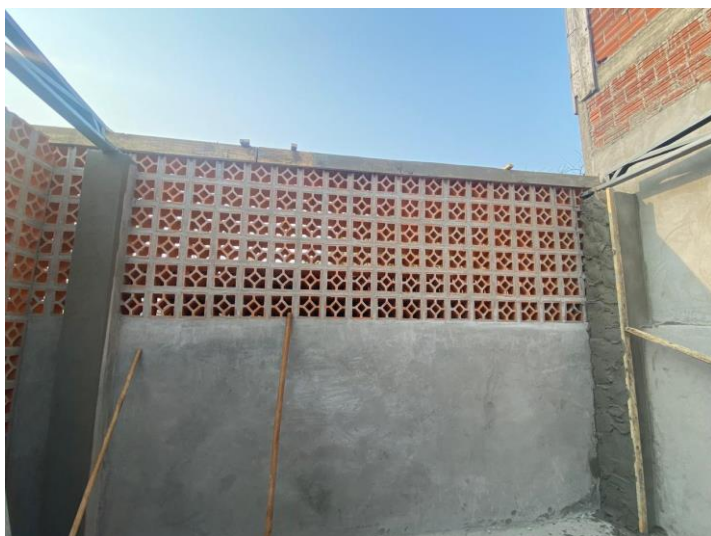
Pilares e parede de cobogó inteira
