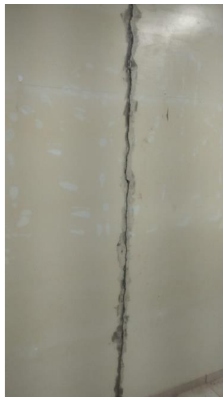
Tratamento de fissura
