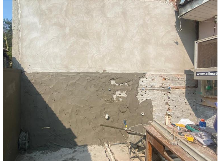
Reboco e pontos de água
