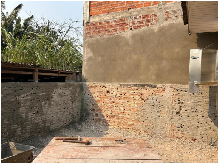
Remoção do reboco
